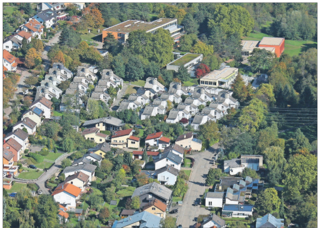
Im mittleren Pavillon der Hebelschule soll eine Kindertagesstätte entstehen. Die Anwohner des Wiesenwegs (rechts von der Bildmitte) fürchten mehr Verkehr und fordern eine Zufahrt zum Kindergarten über die Körnerstraße (links oben).
